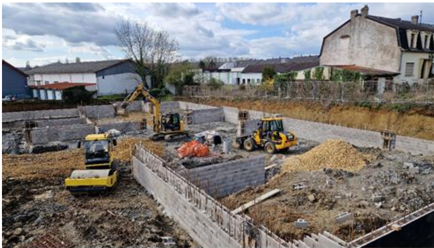
Travaux de construction sous-sol
